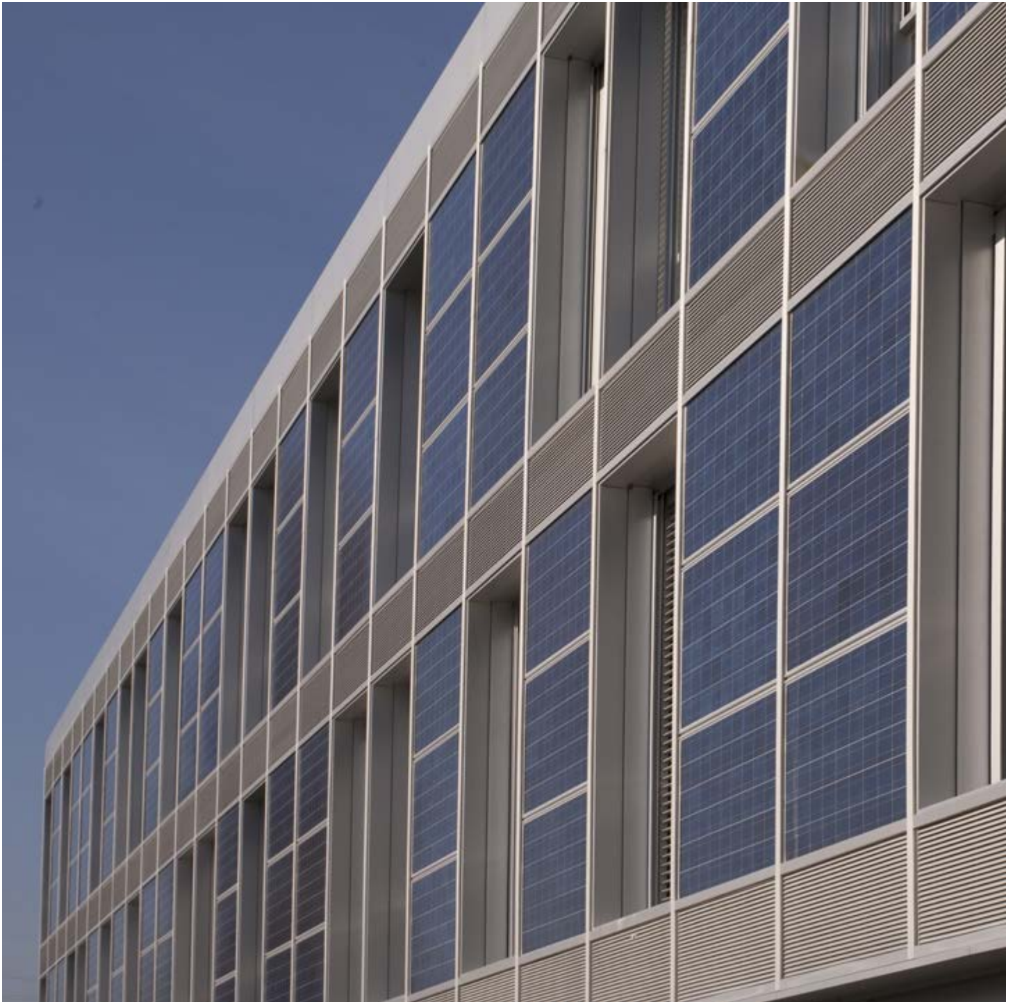
Fig. 6 - La facciata fotovoltaica del Nuovo Polo Tecnologico della Camera di Commercio di Lucca. Progetto: Provincia di Lucca con la consulenza per gli aspetti energetico-ambientali del Centro ABITA. 2010, Lucca (fotografia di ©Veronica Citi).
