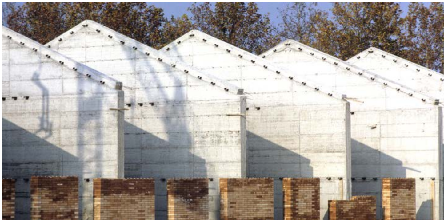
Fig. 3 - Procedimento di realizzazione delle murature esterne, AUtocostruzione CARpenedolo PAUCA (fonte: Costruzione Facilitata , 1985).
