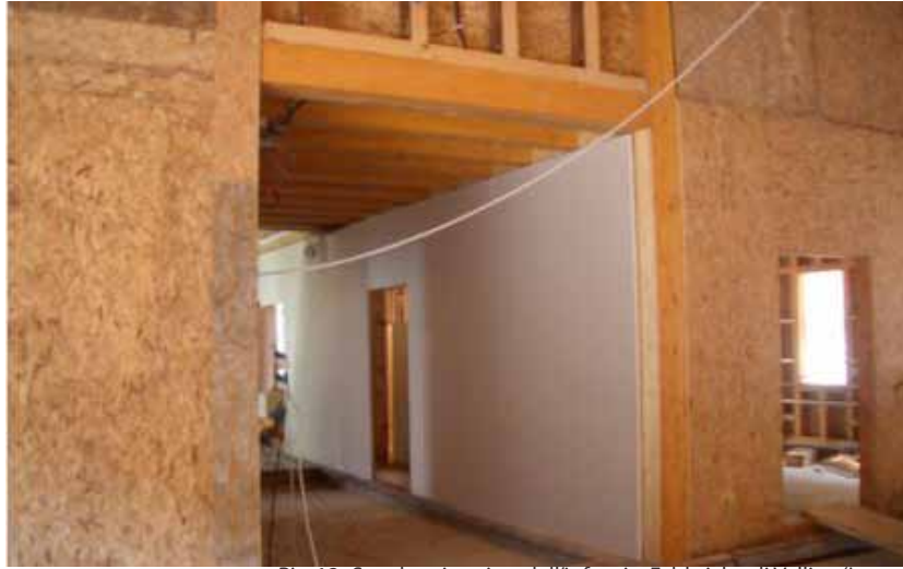
Pic. 12 -Scuola primaria e dell'infanzia, Fabbriche di Vallico (Lucca) La scuola è realizzata interamente con strutture lignee: legno lamellare per le travi curve di copertura, legno massiccio per i telai delle pareti, pannelli di compensato strutturale per i tamponamenti verticali.
