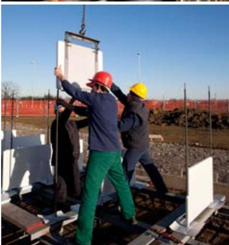
02 | Cantiere, la produzione e l'assemblaggio delle lastre ceramiche (foto Marco Introini)
