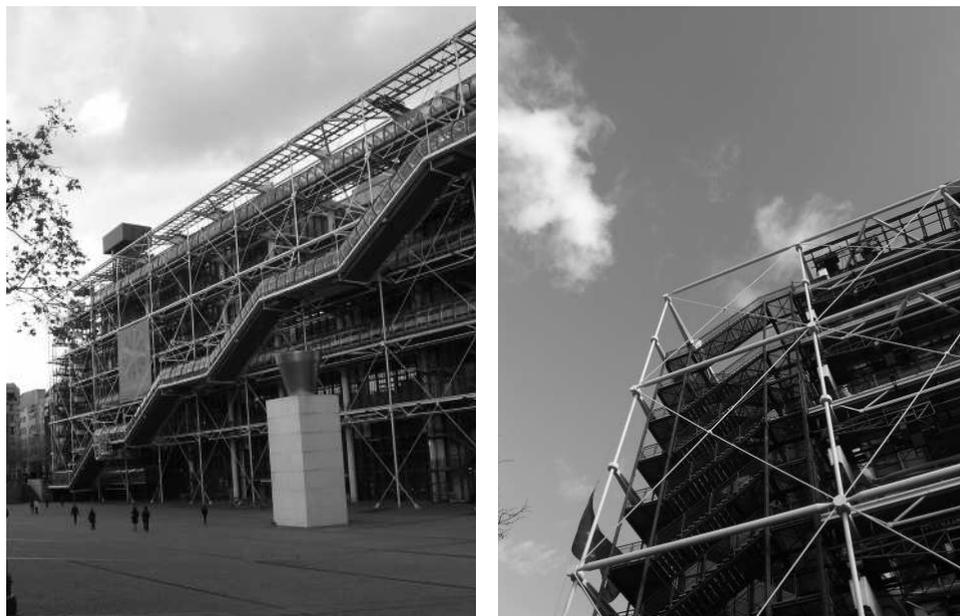
Fig. 2.2: Centre Pompidou, Renzo Piano e Richard Rogers, Parigi, Francia, 1977. L'edificio, diventato ormai un'icona dell'architettura contemporanea, si caratterizza per la scelta di trasformare la rete impiantistica in elemento estetico caratterizzante l'involucro architettonico.
