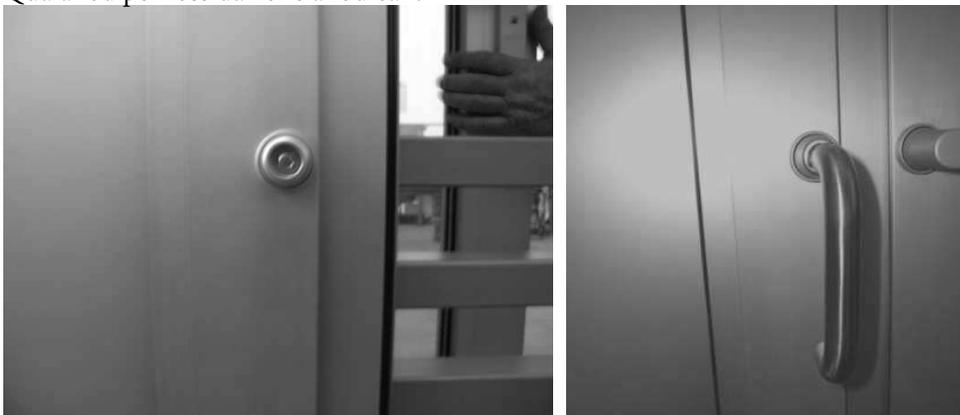
Fig. 5.14. Prototipo: maniglia a scomparsa dell'anta opaca del componente di facciata
