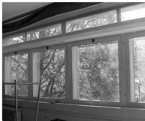
Fig. 4.14 e 4.15: Vetro con applicazione di gel fotovoltaico
