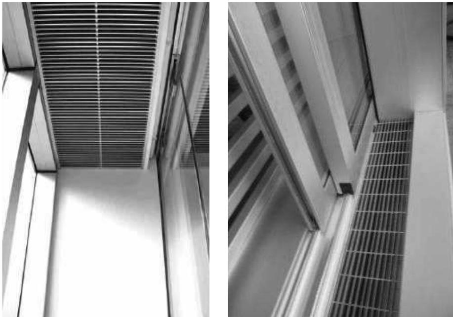
Fig. 3.16: Particolare di bocchetta di ventilazione da applicare all'interno dell'intercapedine
